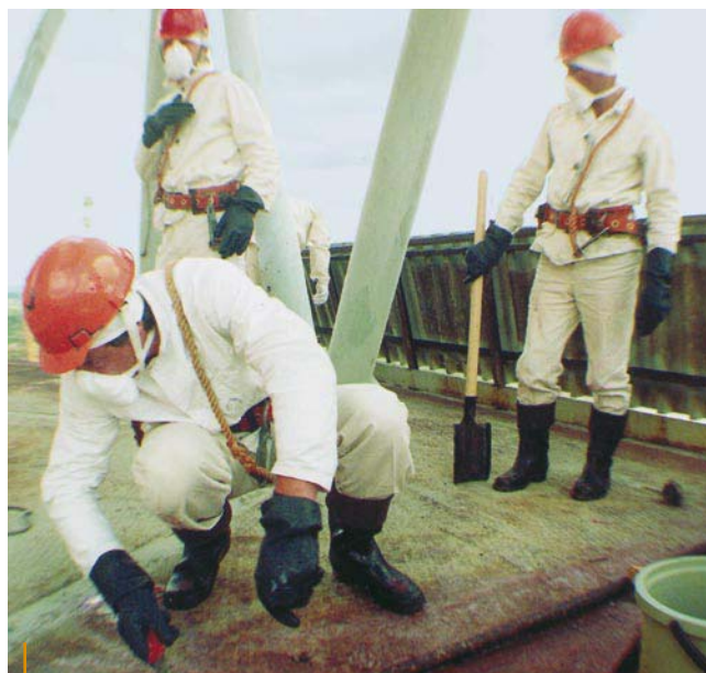
Dekontaminationsmaßnahmen auf dem Dach des Sarkophags
